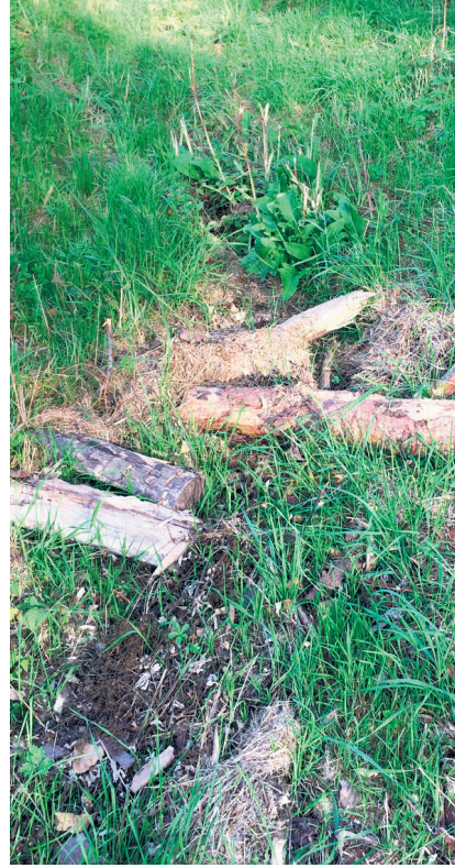
Ein mit Erdreich verdeckter und mit Gras verwachsener Schacht
