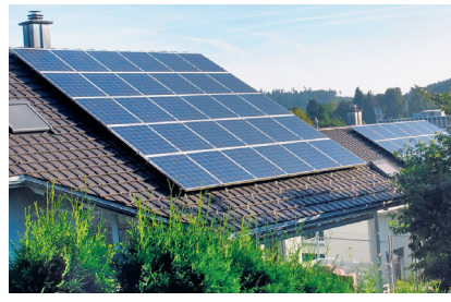
Die Produktion von Solarstrom ist beim Heizungsersatz oft eine gute Ergänzung.
