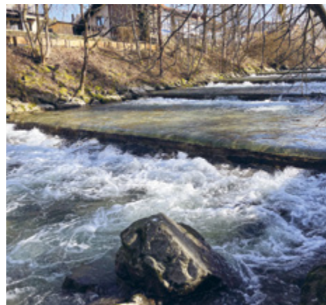
Holzschwellen in der Murg beeinträchtigen die Fischgängigkeit (Blickrichtung flussaufwärts)
