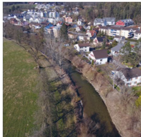
Gerinne der Murg ohne Breiten- und Tiefenvariabilität (Blickrichtung flussabwärts)
